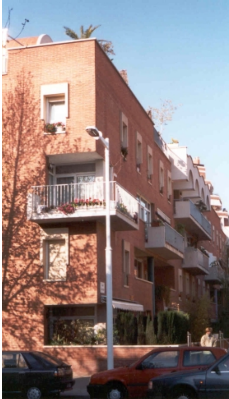
Figura 2.13 Se puede apreciar como el tabique se mezcla con otros elementos arquitectónicos como los balcones dando interesantes visuales
