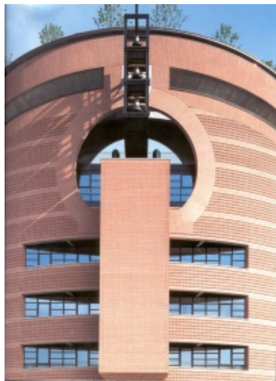
Figura 2.8 Fachada principal de la capilla
