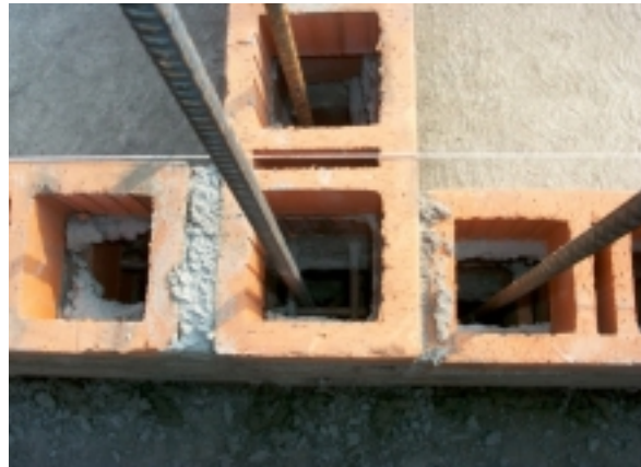
Figura 6.15 Detalle de piezas huecas con refuerzo interior
