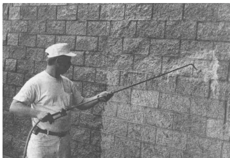
Figura 9.55 Aplicación de hidrofugante
