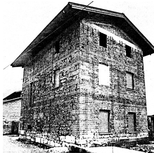
Figura 11.27 Encamisado con mallas metálicas después del sismo de Friuli, Italia en 1976
