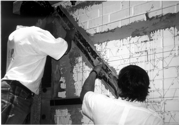
Figura 11.38 Colocación de bandas de fibras de carbón
