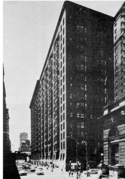
Figura 1.12 Edificio Monadnock, Chicago 1891
