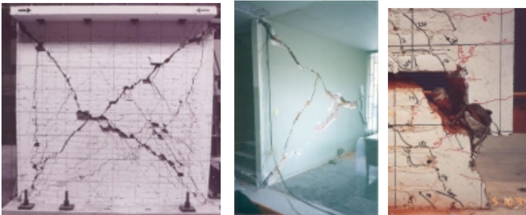
Figura 6.12 Penetración de grietas inclinadas en los extremos de castillos y plegamiento de las barras longitudinales (Aguilar, 1997)
