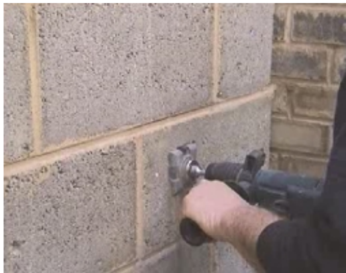
Figura 9.53 Ranuración de muros
