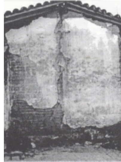
Figura 6.1 Falla por flexión fuera del plano (Sordo y otros, 1996)
