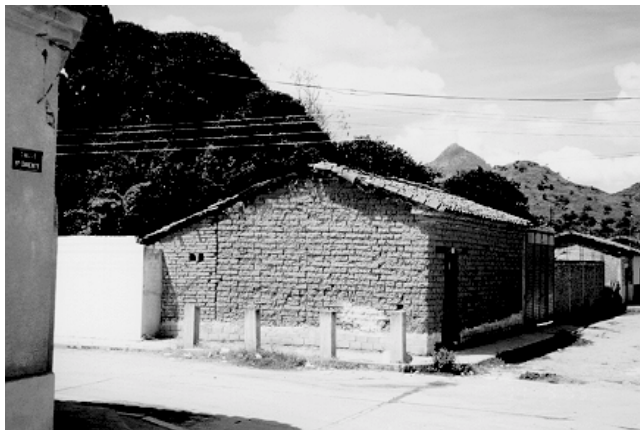
Figura 11.50 Vivienda de adobe típica del estado de Chiapas
