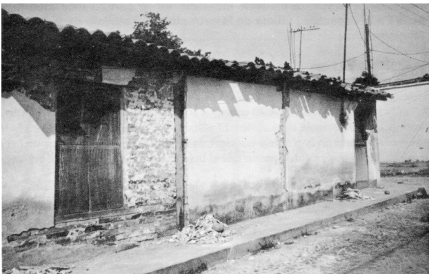
Figura 6.2 Construcción de adobe confinada con polines de madera (López y Teshigawara, 1997)
