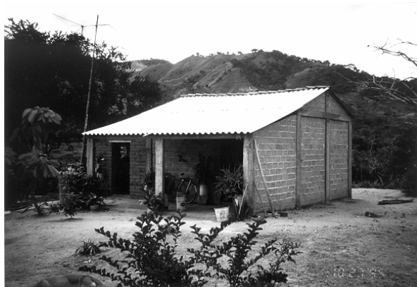
Figura 11.62 Vivienda de mampostería con techo ligero
