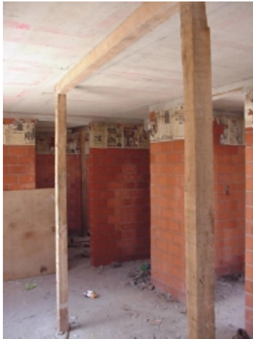
Figura 10.9 Apuntalamiento de losas después de descimbrar
