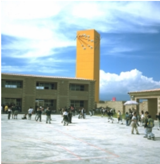
Figura 9.88 Escuela con muros de bloque de concreto
