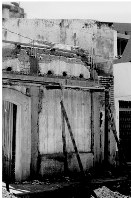
Figura 11.58 Adición de elementos de confinamiento en una vivienda de adobe
