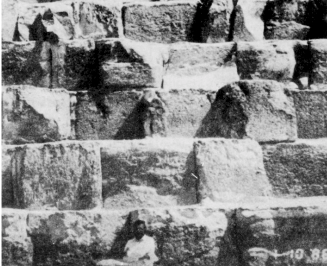
Figura 1.7 Monolitos de cuatro toneladas en el núcleo de las grandes pirámides en la vecindad de El Cairo, Egipto
