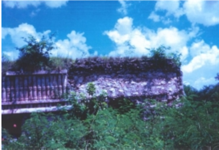
Figura 1.4 Recubrimiento de piedra bajo el cual se encuentra el muro de carga construido con el concreto maya
