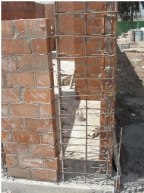
Figura 10.6 Conexión entre muros de mampostería y de concreto
