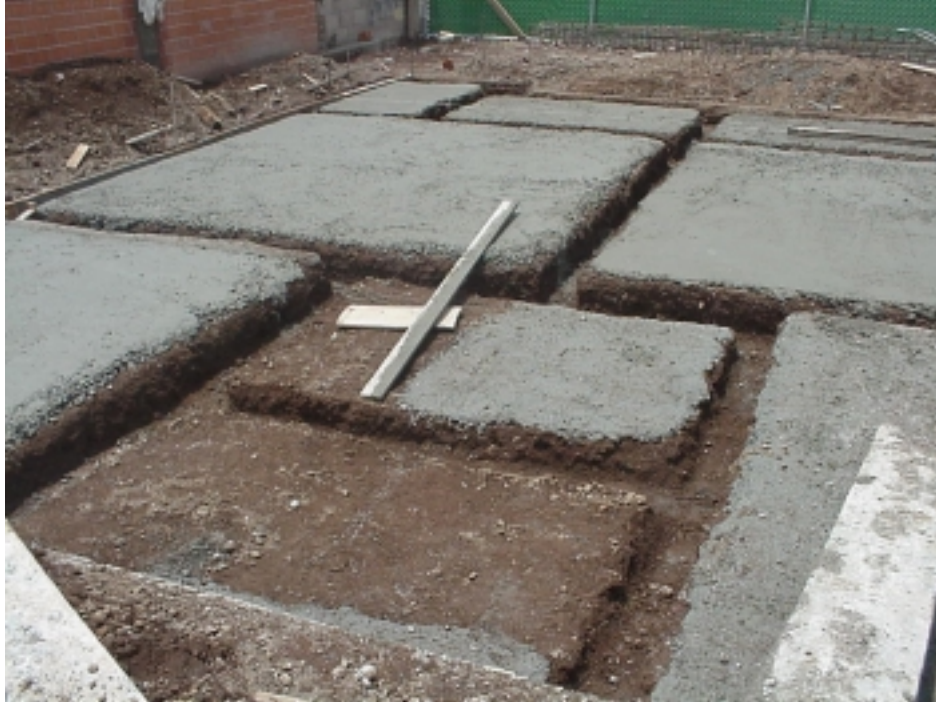
Figura 10.7 Excavación para la cimentación
