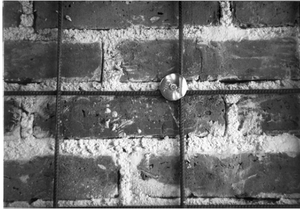
Figura 11.32 Malla metálica anclada a un muro de mampostería con conectores Hilti
