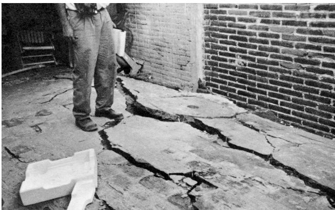
Figura 6.10 Asentamiento de debido al fenómeno de licuación de arenas (López y Teshigawara, 1997)
