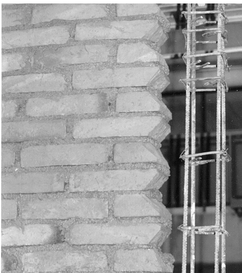
Figura 9.4 Dentado de un muro de tabique recocido para garantizar el "amarre" con los castillos de confinamiento
