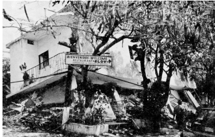
Figura 6.9 Colapso debido a la escasez de muros en planta baja (López y Teshigawara, 1997)
