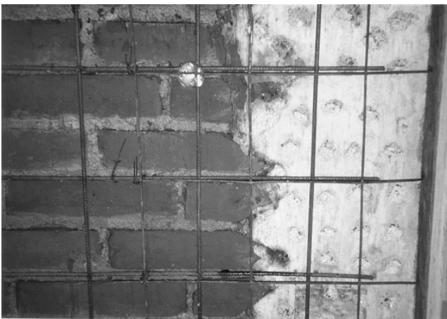
Figura 11.34 Confinamiento de un castillo con mallas metálicas que han sido traslapadas
