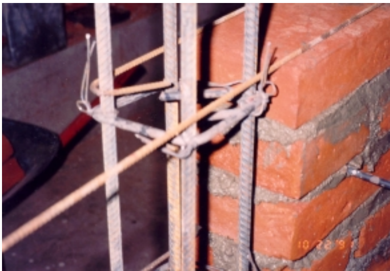
Figura 6.26 Anclaje de un alambre corrugado de 5/32" en el acero longitudinal de un castillo (Sánchez y otros, 1992)
