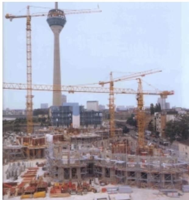
Figura 9.58 Grúas torre en obras de gran altura
