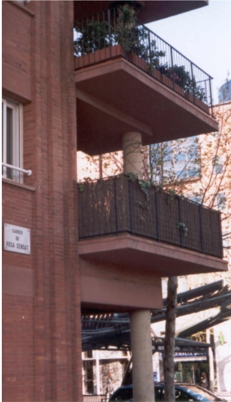
Figura 2.14 Tratamiento para una esquina en la ciudad de Madrid
