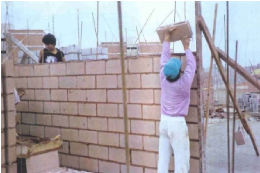
Figura 9.56 Sin medios adecuados es imposible hacer un trabajo productivo y con calidad
