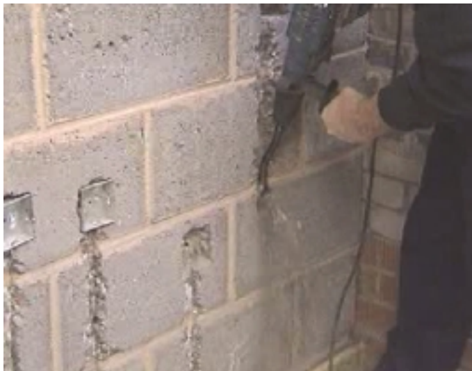
Figura 9.54 Muros ranurados para instalaciones
